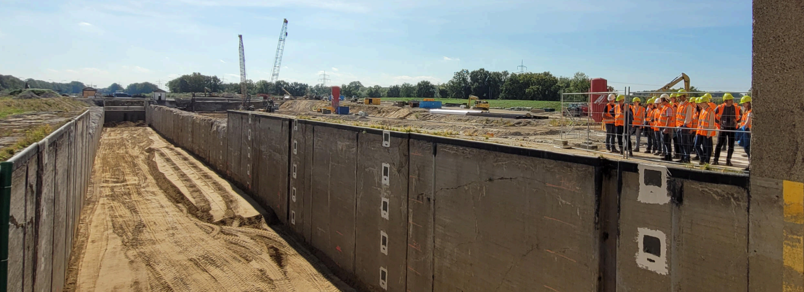
Bild oben: Auffüllung und Teilrückbau der alten Schleusen-kammer
