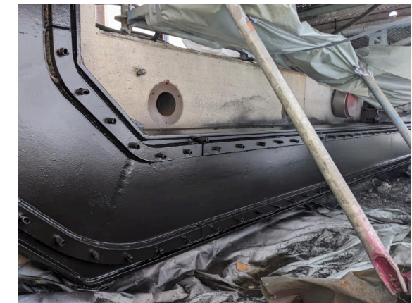
Bild links: Ventil an der Außenseite des Tunnels, um die Tunnelelemente in Endlage mit Sand zu unterspülen. Zur Orientierung der Taucher, die sie später betätigen, sind römische Ziffern angebracht.
