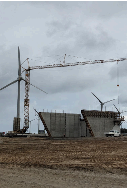
Bild: Brückenwiderlager einer Brücke auf Fehmarn über die B207
