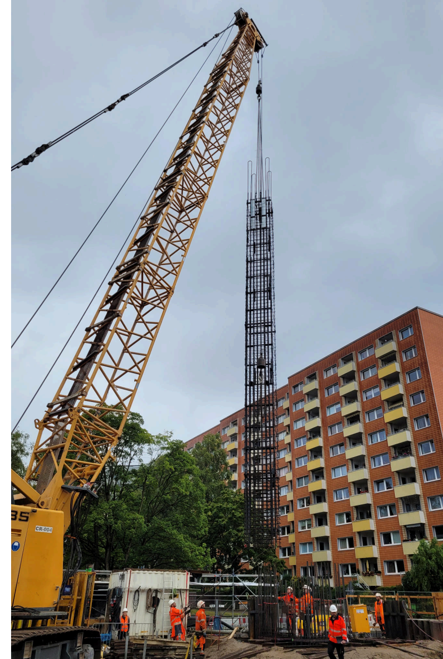
Bild oben: Einstellen eines Bewehrungskorbs in den ausgehobenen Schlitz
