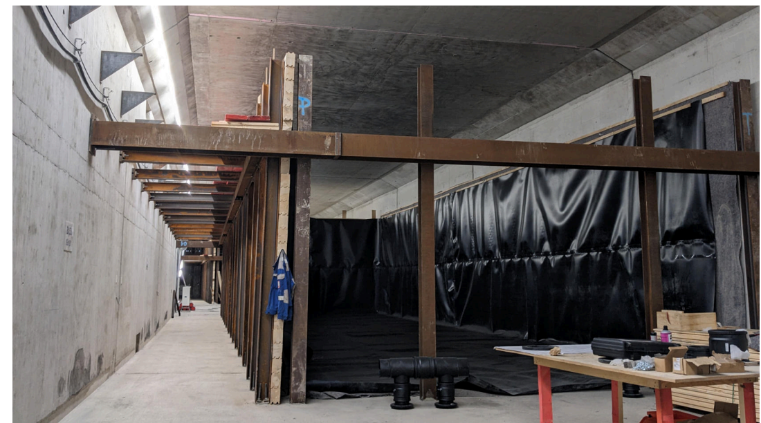
Bild unten: Fast fertige Ballastkammer im Inneren eines Tunnelelements
