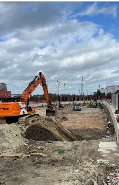
Bild: Aushubarbeiten an der Absenkrinne
