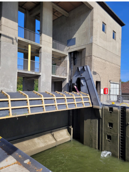
Bild Mitte rechts: Mechanismus zum Bewegen des Schleusentors der alten Schleuse
